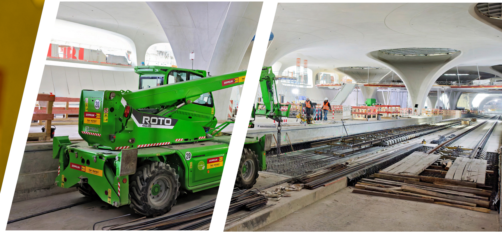
Die eingesetzten Heizungen unterstützen den Bau der charakteristischen Lichtaugen. Auch Teleskopstapler sind vor Ort im Einsatz
