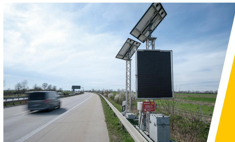
Mit Sonnenenergie werden die LED-Anzeigetafeln versorgt. Die Solarpanels verfügen auch über einen Stromspeicher, sodass immer ausreichend Strom vorhanden ist
