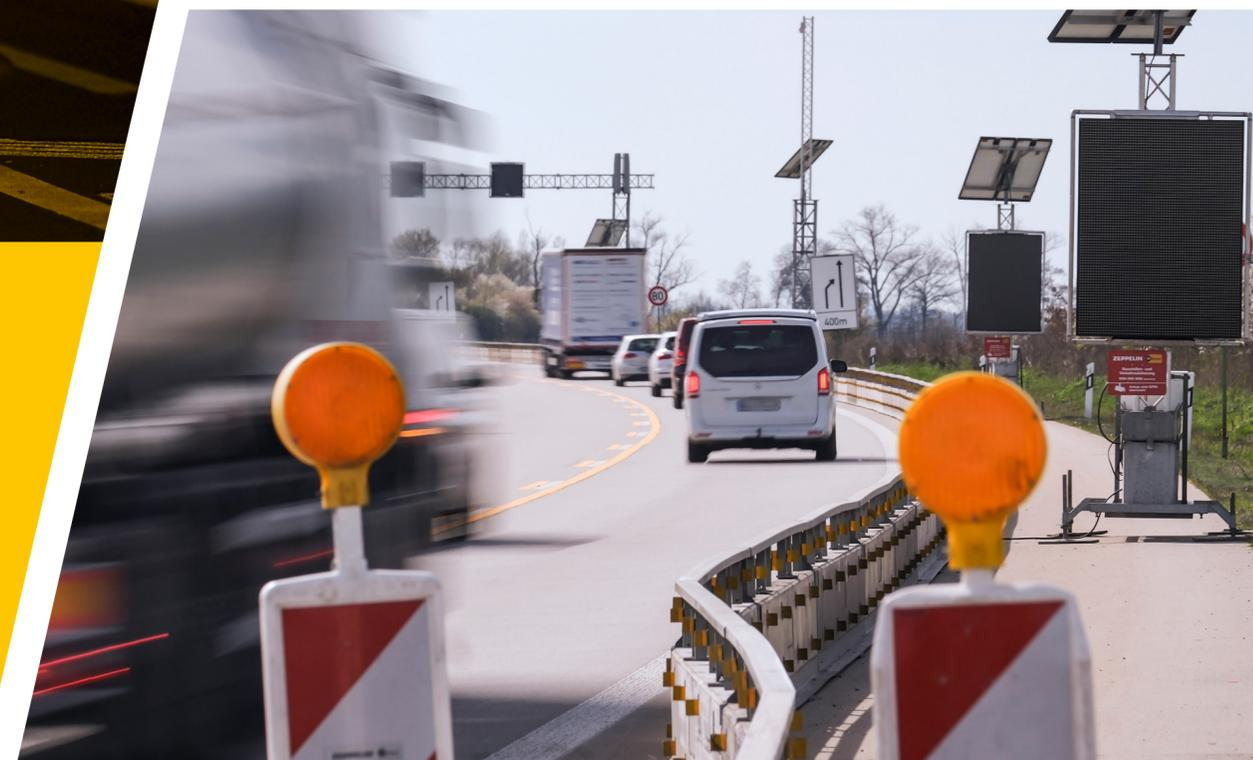
Um eine bauliche Abgrenzung zu schaffen, wurden 20 Kilometer temporäre Schutzeinrichtungen aufgebaut und 23 Kilometer gelbe Markierungsfolie verlegt
